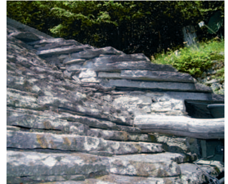
Il riscontro: tetto in piastre di granito squadrate e tagliate; care in fase di costruzione, ma impermeabili e praticamente senza necessità di manutenzione.
