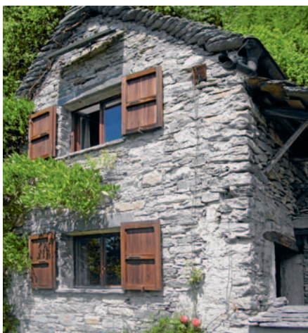
Typisches, einfach ausgebautes, sehr funktionelles Rustico – mit eigener Kläranlage
